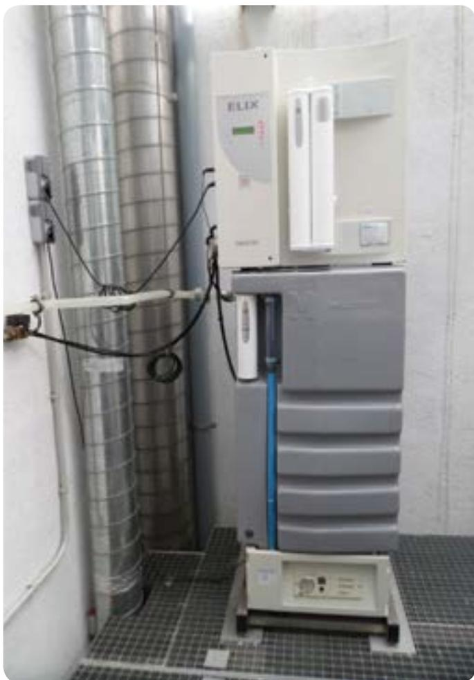
Sistema de purificación de agua Elix® 35 con sistema de almacenamiento y distribución SDS.
